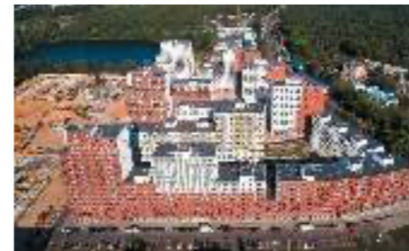
ЖК «Новокрасово», МО «Тройка РЭД»
